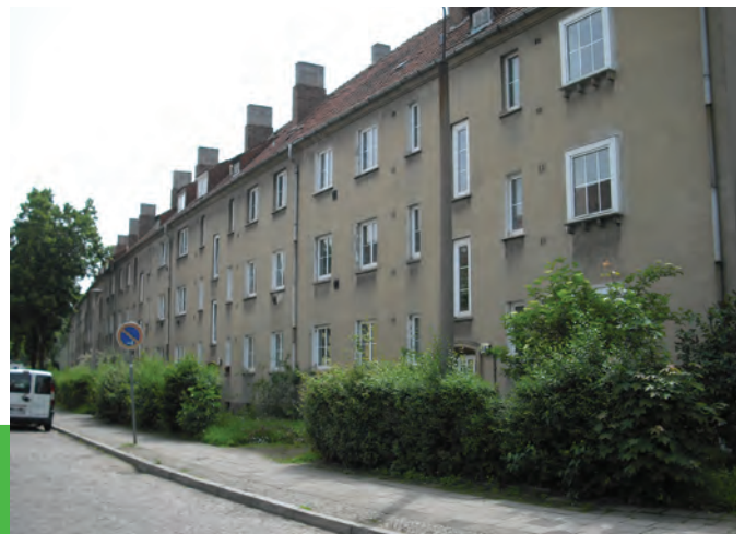
Objekt vor der Sanierung: Dr.-Martin-Luther-Str. 37-49 Kinderstube
