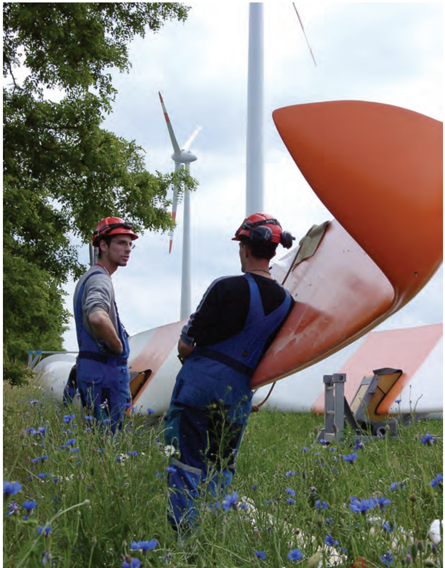
Aufbau von Windenergieanlagen
