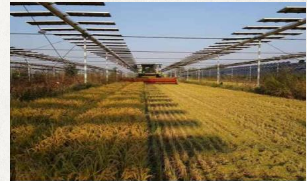
Hoch aufgeständerte Anlage mit schmalen PV-Modulen. © REM Tec
