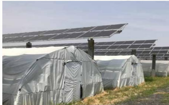
PV-Module über einem Folientunnel © BayWa r.e.
