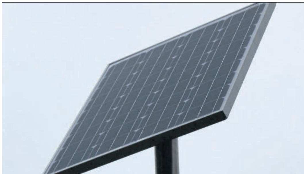
Energie kann über ein Solarmodul erzeugt werden. Bürgermeister Norman Klebe will im nächsten Jahr die ersten Straßen komplett mit der neuen Lichttechnik ausrüsten lassen. Fotos (3): Ziems
